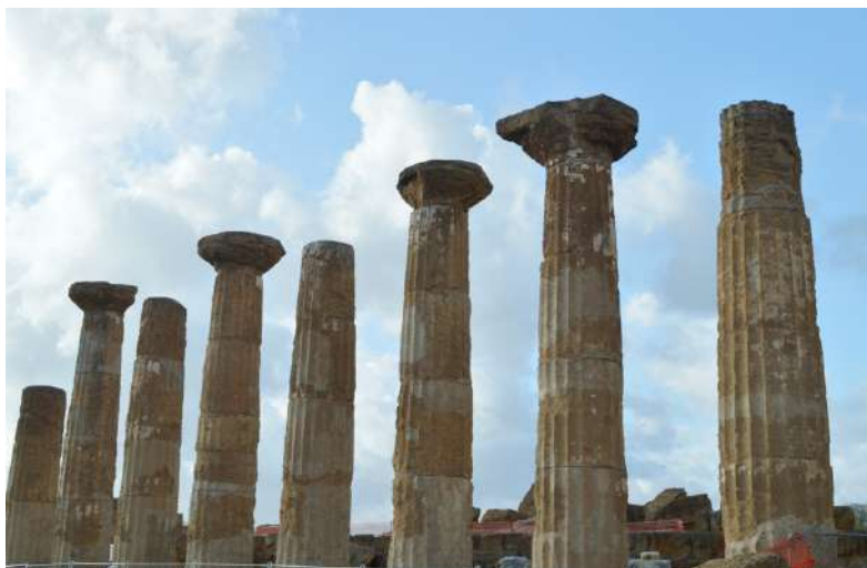
Fig. 3.24 – Agrigento: particolare delle colonne doriche del tempio Greco di Giunone. Le calcareniti utilizzate per costruire le colonne sono fortemente abrase dagli agenti atmosferici.
